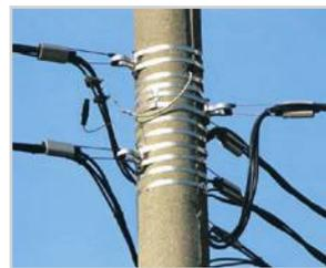
Для крепления провода СИП на опорах и фасадах зданий, подключения потребителей (абонентов), подключения СИП к неизолированным линиям, а так же для ввода в трансформаторные подстанции и соединения с силовым кабелем.
