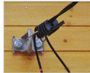
Подвижный клин не требует монтажного инструмента и обеспечивает надежную фиксацию проводника.
