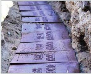
Для сигнализации и механической защиты электрических кабелей, проложенных в грунте, работающих под напряжением до 35 кВ.
